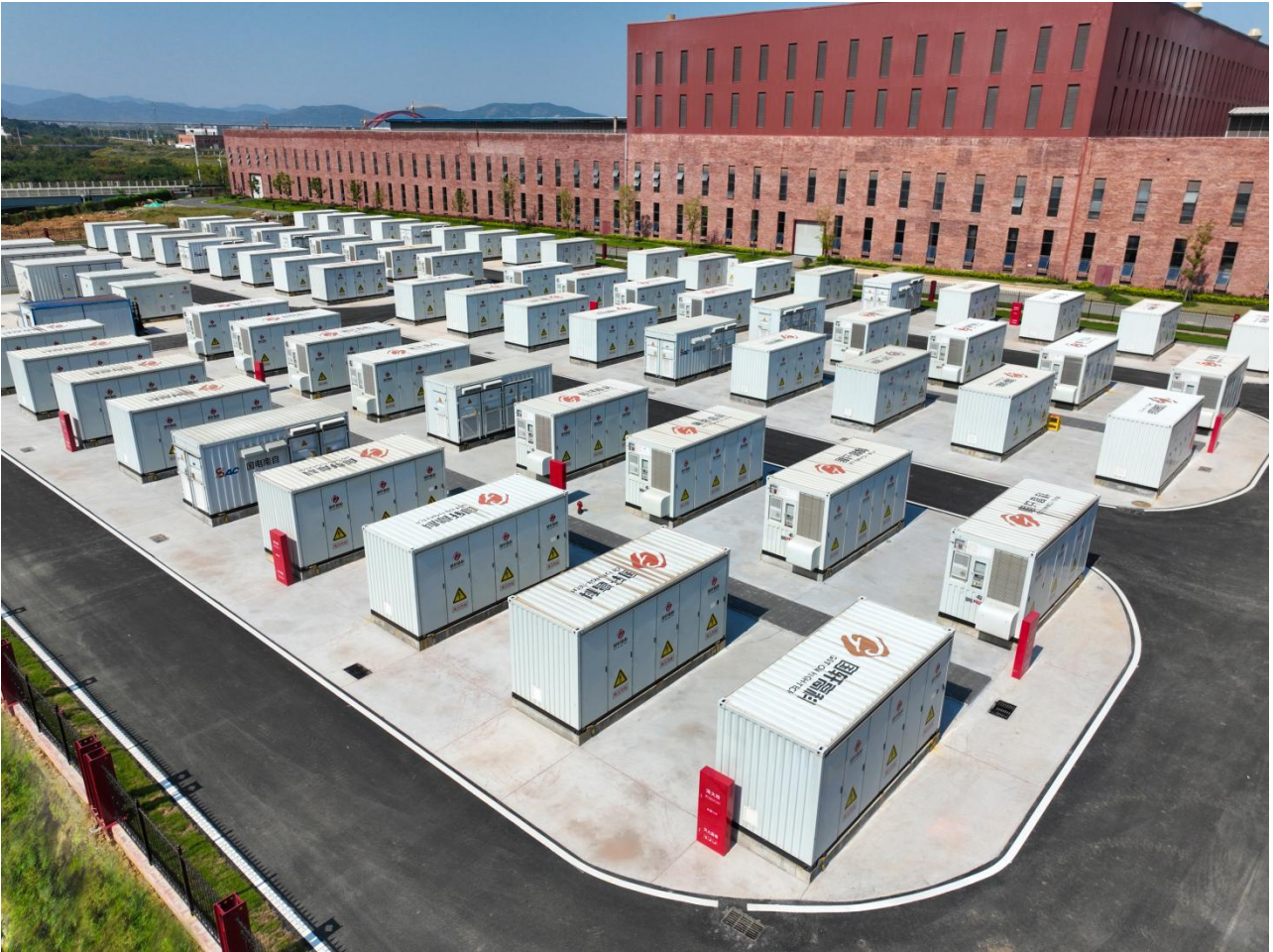
※中国安徽省合肥市廬江/国軒高科廬江工場での設置風景
